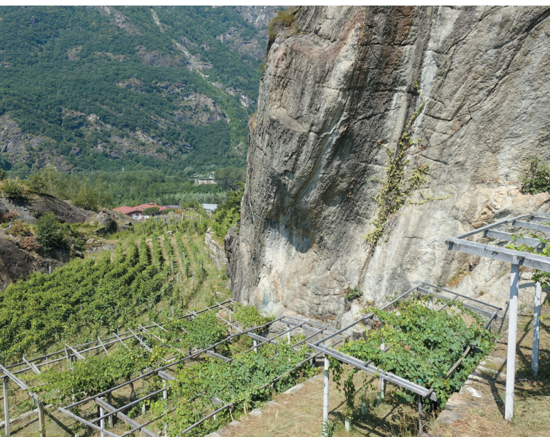
I nuovi impianti di pergola vengono realizzati in legno e cemento
